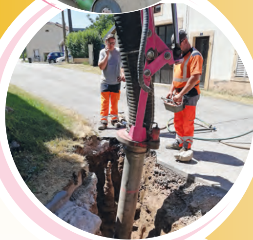
Travaux d'eau juillet 2019
